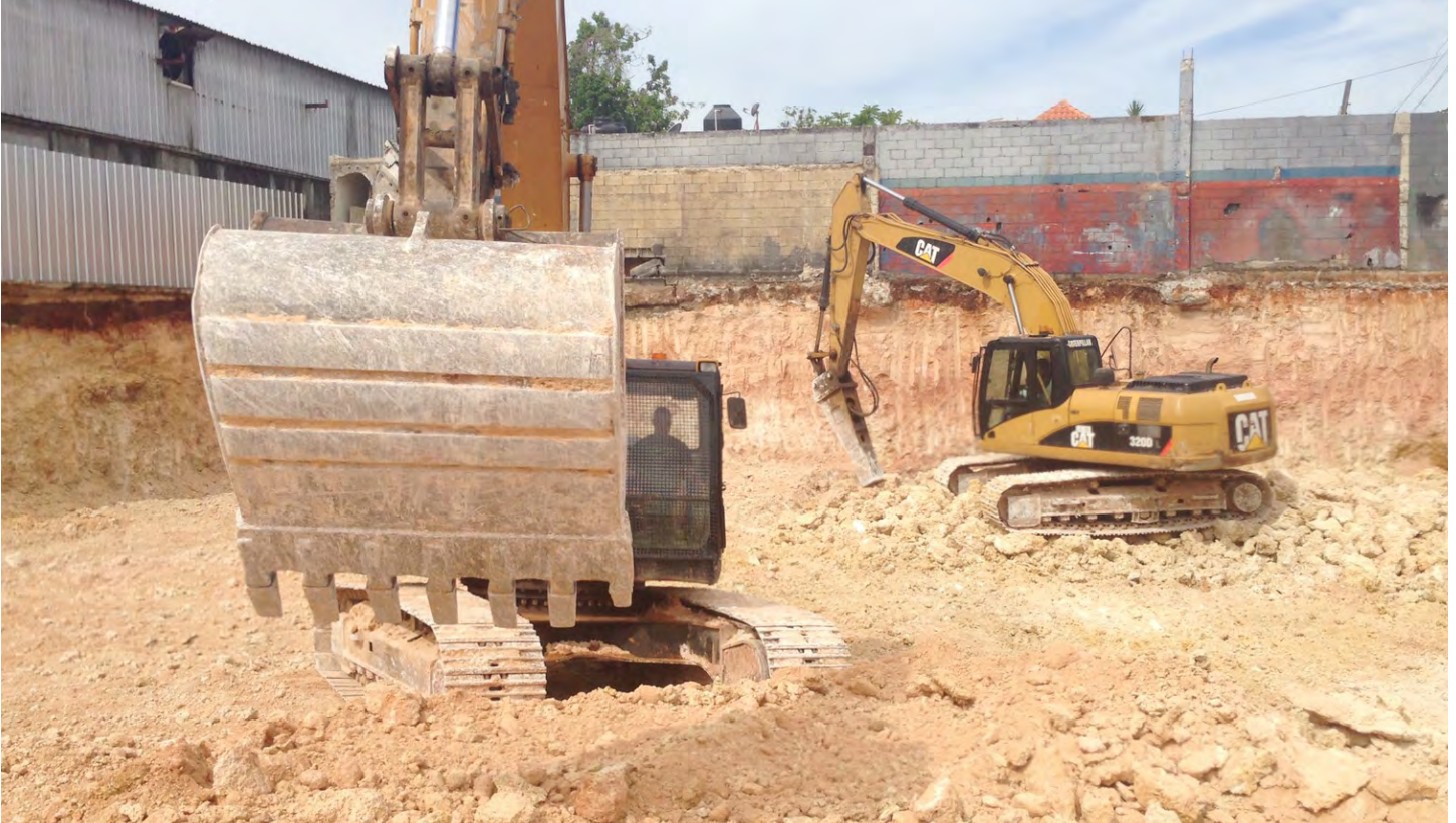
Excavación Onix XVIII
